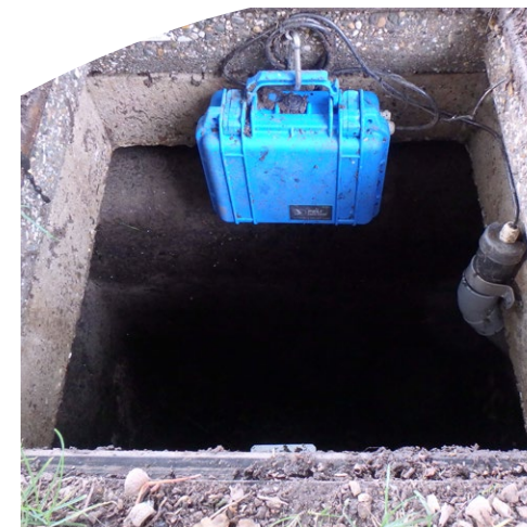
Foto: Metten aan riolering.
