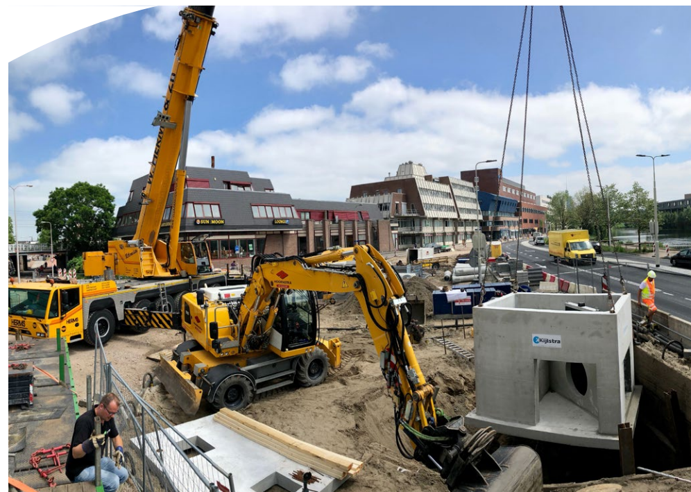
Foto: werkzaamheden Brinkgrevertunnel.
