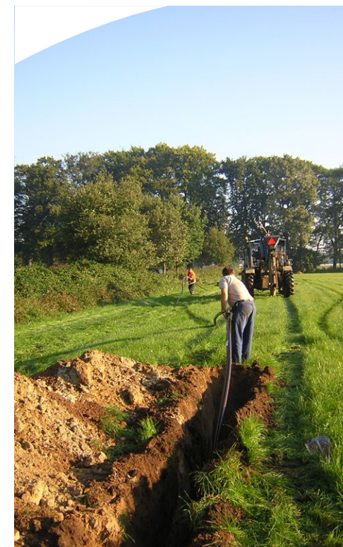
Foto aanleg persleiding in het buitengebied.
