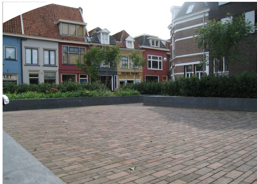
Foto: Waterpasserende verharding Lamme van Deseplein.
